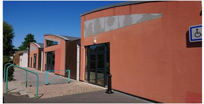
Les portes et portes-fenêtres de la salle des fêtes et de la cuisine ont été changées par l'entreprise EVMS pour remplacer le simple-vitrage en double-vitrage (isolation thermique) avec un bas plein pour éviter les bris de vitre. 2 des huisseries cintrées ont été condamnées (entreprise F.S.C.Menuiserie) car elles étaient inutiles. L'enduit et la peinture seront refaits pendant l'été par l'équipe technique.
